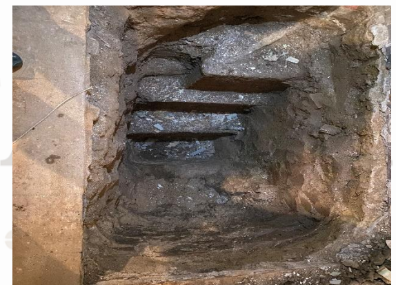
Fundamentfreilegung bis auf 3 m Tief
