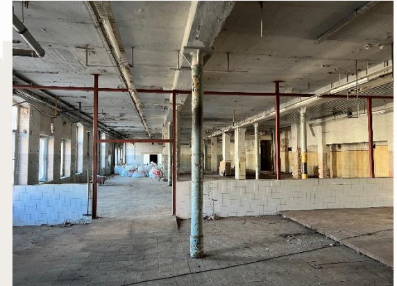
Entsorgung alter Dämmung und Entrümpelung
