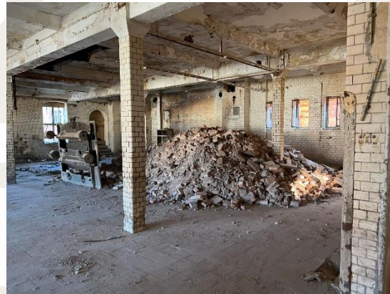
Abriss alter Backofen
