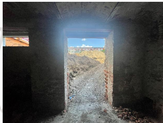
Kellereinfahrt für Minibagger
