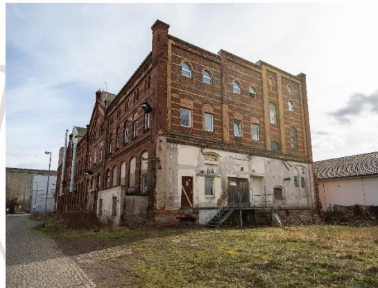
Außenansicht mit Schornsteinen
