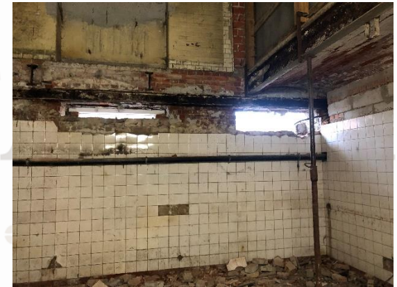
Durchbruch ehem. Fensteröffnung
