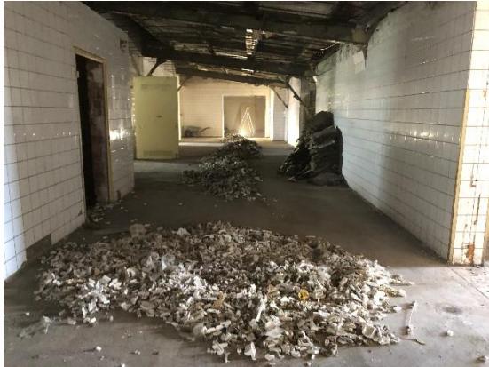
Abriss alter Deckenplatten
