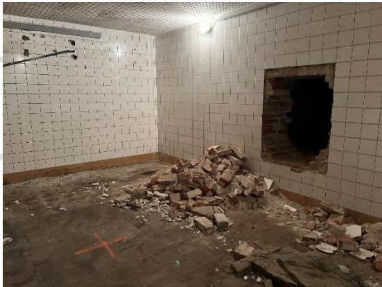
Überprüfung vorhandener Schächte, Fundamente
