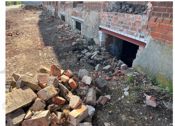
setzen neuer Fensterstürze
