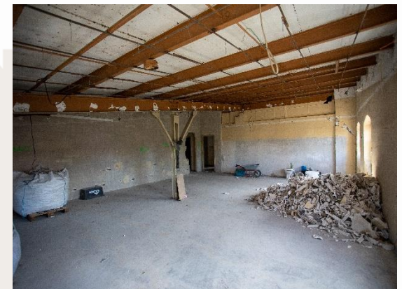
Abriss alte Deckenplatten
