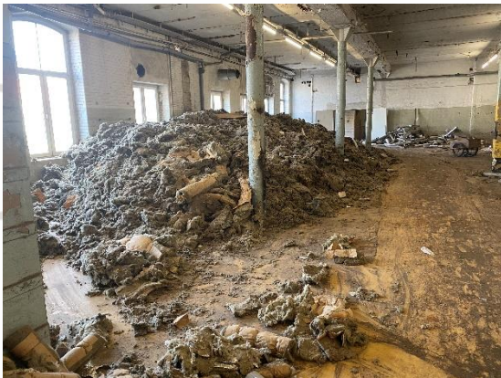
Entsorgung der Dämmwolle aus den Öfen
