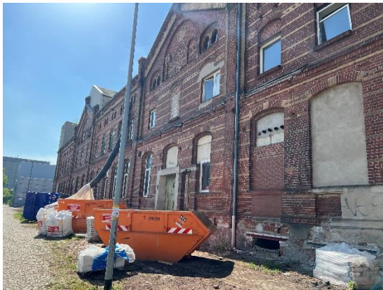
Container Abriss Innenwände, Decken, Böden
