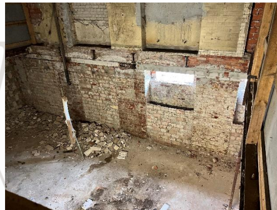
Entfernung alter Fliesen
