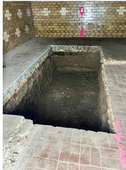
Grube neues Fundament
