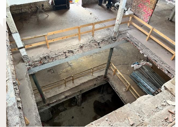
Blick vom 2. OG in das Treppenauge
