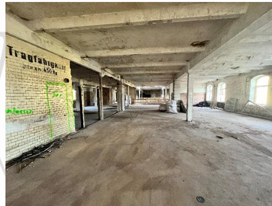
Blick ins 1. Obergeschoss
