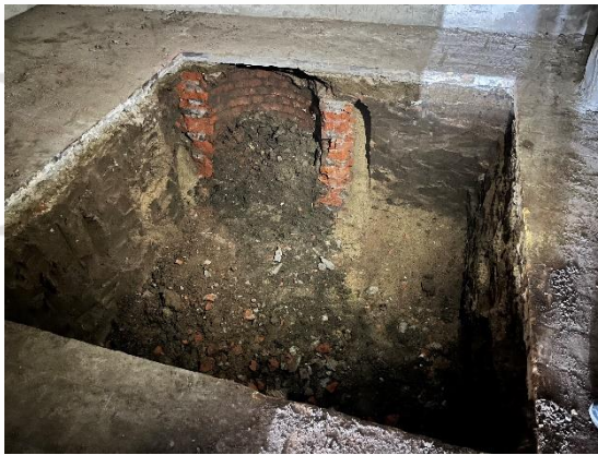
Fundamentgrube mit alten Zug
