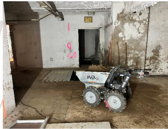
Beräumung mittels Dumper
