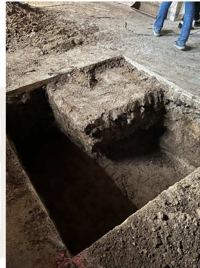
Grube neues Fundament
