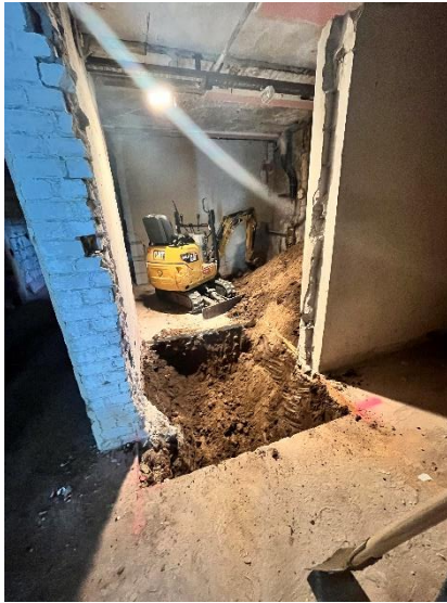
Minibagger für neue Fundamente
