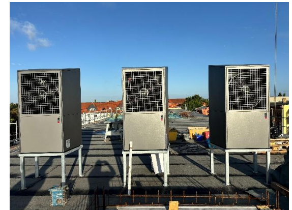
die Luftwärmepumpen wurden auf dem Dach installiert
