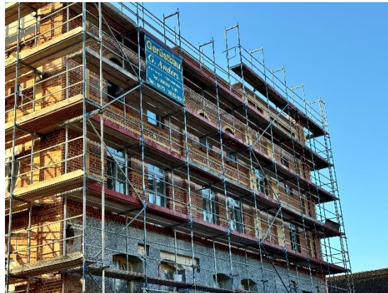
Die Sanierung der Westfassade im Klinkerbereich ist abgeschlossen
