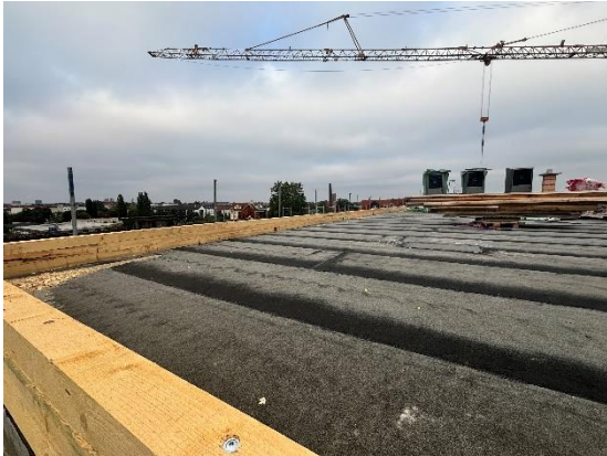
nach der ersten Dachhaut wurde die Attika erstellt
